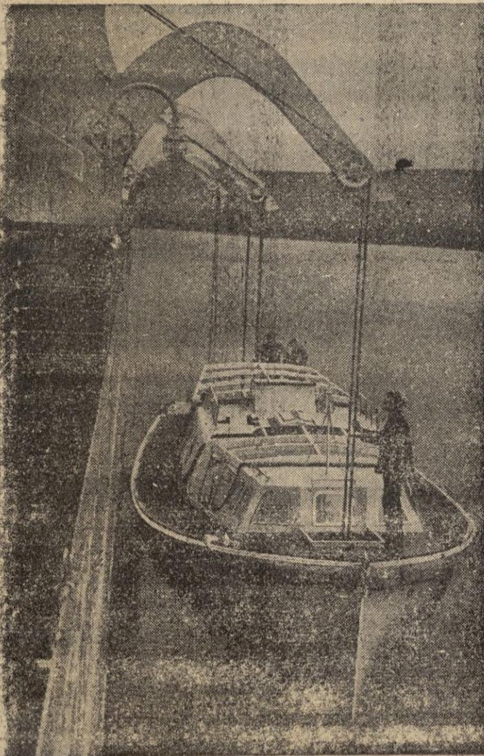
Actualmente, independientemente de los ensayos que se hacen con los vehículos de carretera, se prueba con las lanchas motoras la aplicación del caucho que proteja todo el contorno. He aquí una de las lanchas dispuestas a ser lanzada de un muelle para probar el experimento
