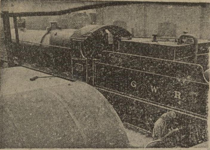
Las compañías de ferrocarriles de la Gran Bretaña han acordado el problema para que las locomotoras en vez de carbón consuman combustibles líquidos, lo que permitirá ahorrar un millón de toneladas de carbón al año. Véase una locomotora repostando, como si fuera un automóvil
