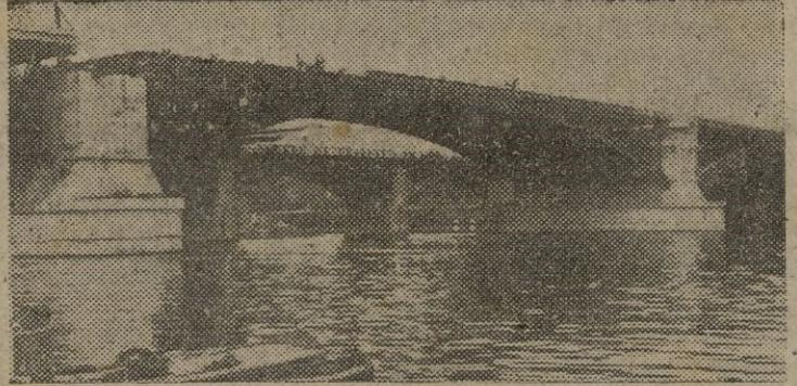
EL PUENTE D'ARGENTEUIL.—El viejo puente d'Argenteuil, averiado durante la guerra, va a ser reconstruido. Los 6 arcos excesivamente estrechos que dificultaban la navegación fluvial están siendo reemplazados por 3 arcos metálicos. El piso del puente sufrirá una considerable elevación de forma que permita el paso de los remolcadores. El monumento del puente d'Argenteuil fué inaugurado recientemente. El nuevo puente será abierto a la circulación en el próximo mes de Julio (Scrip)
