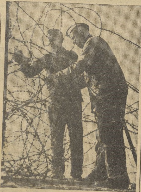
A lo largo de toda la costa atlántica, soldados alemanes y obreros de la organización Todt han construido fortificaciones contra ataques eventuales. Aquí se ven zapadores construyendo una barrera de alambrado
