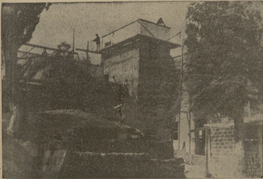
Obra posterior del la parte Norte
