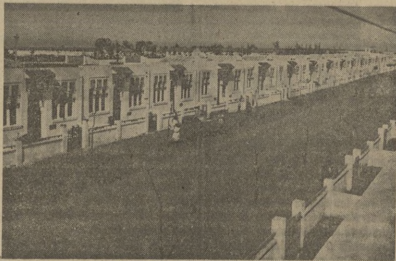
Barriada de casas baratas para musulmanes. Llenas de sol y luz, cautivan a sus moradores.
