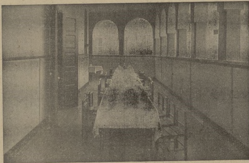
CANTINA ESCOLAR Y NLA ESCUELA MARROQUI DE ALCAZARQUIVIR
