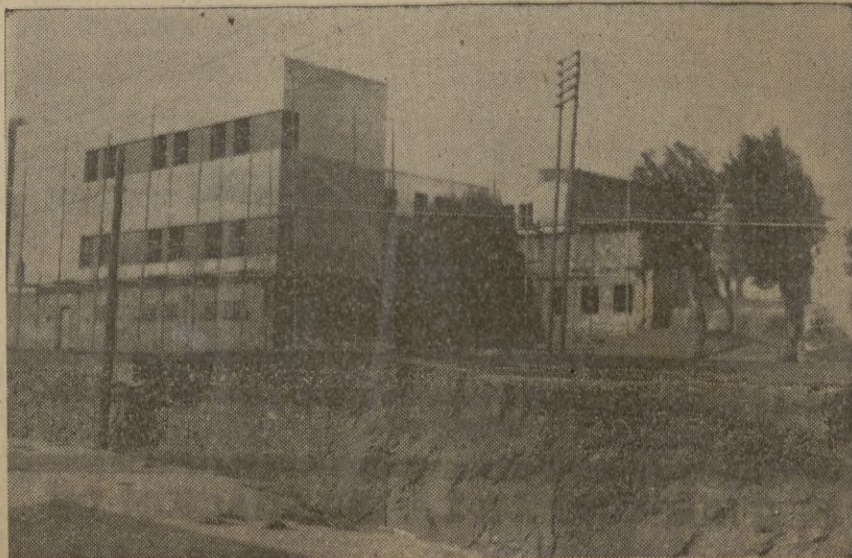
Obras realizadas en la construcción, por su parte Sur
