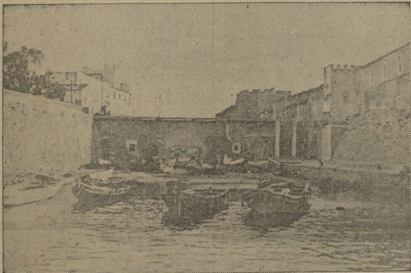
Puente de la Almina, en el año 1908
