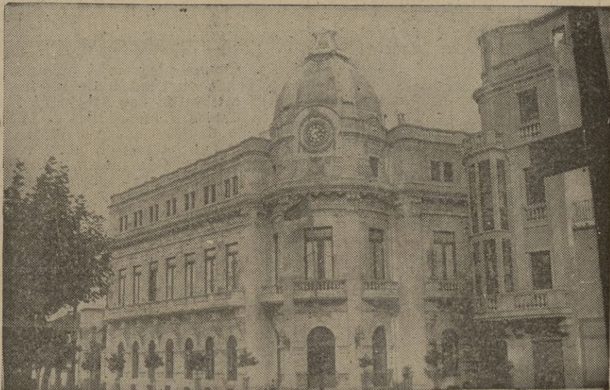
El soberbio edificio del Ayuntamiento de Ceuta
