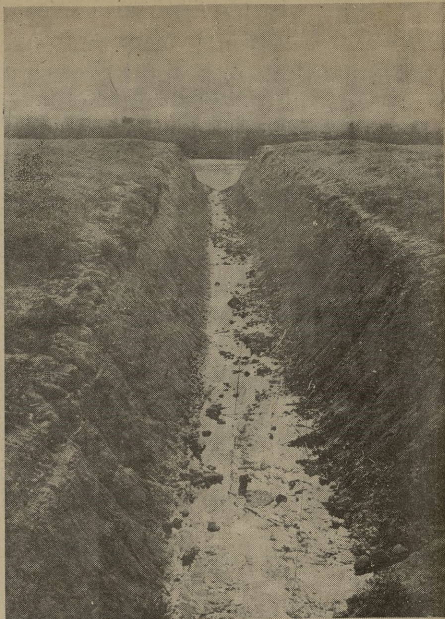
Canal de desagüe al Río de las Zanjás que sanean el aeródromo y sus alrededores, vease el efecto benefactor varios días después de una avenida
