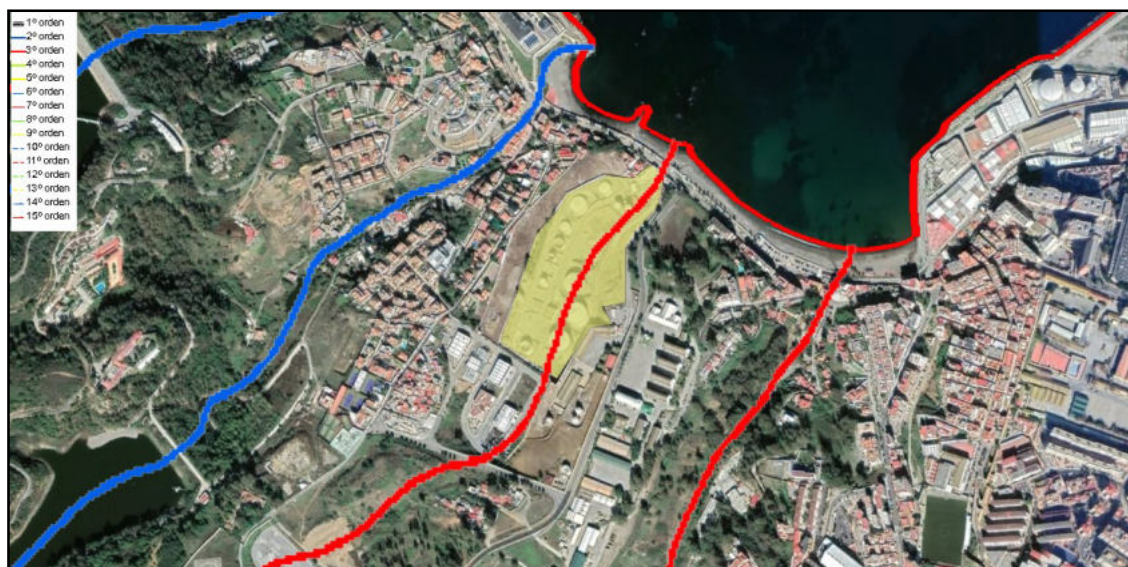
Ilustración 34: Factoría de combustible afectada por el barranco de Sanroma
