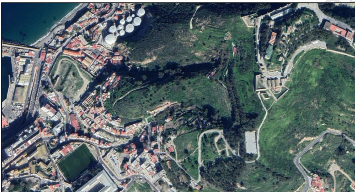
Ilustración 24: Zona del Monte Hacho con problemas de desprendimientos de laderas
